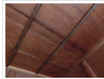
● 茶室の杉板天井
